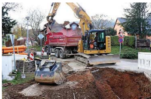
Baumaßnahme in der Griesbachstraße in Bad Blankenburg: Mitarbeiter der Baufirma bei Vorbereitungsarbeiten für die Verlegung des Abwasserkanals. FOTO: ROBERTO BURIAN
